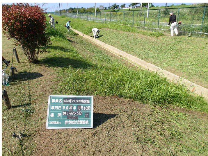
【除草・清掃現場 例】
